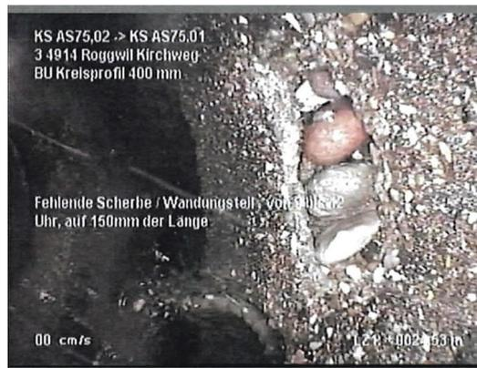
Abbildung 8: Ausbruch Rohrwand Kilchweg
